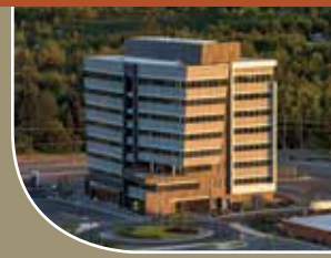
FBC Tenant Expansion
